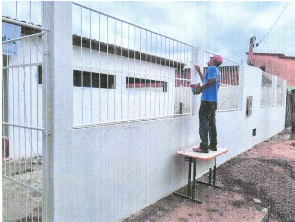
FOTO 20 – EXECUÇÃO DE PINTURA EM ESTRUTURA METÁLICA
