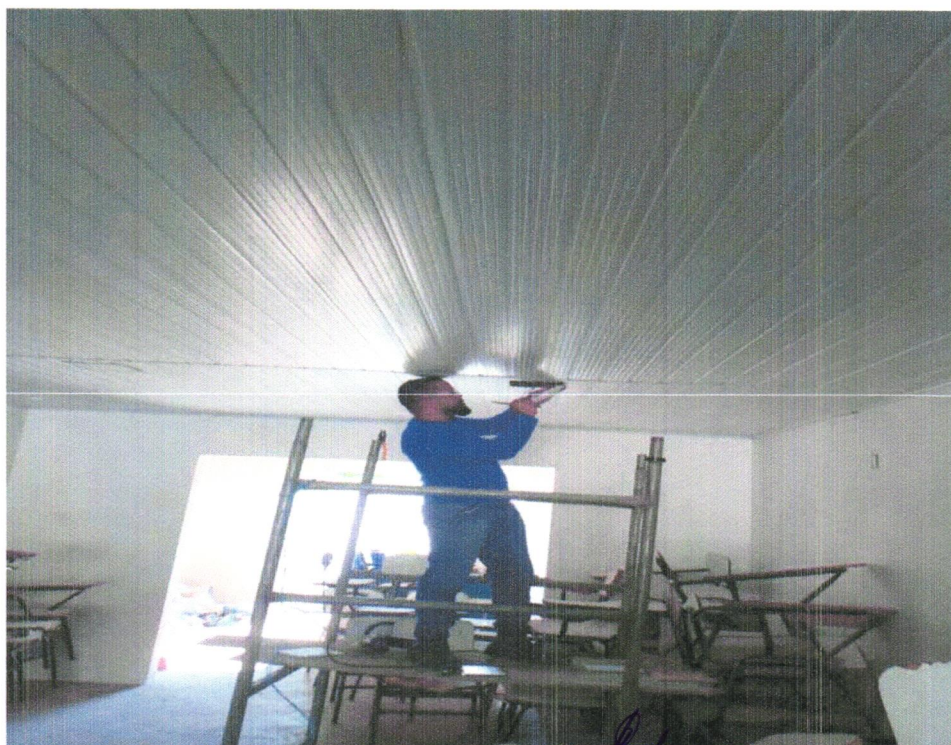
FOTO 12 – INSTALAÇÃO DE LUMINÁRIAS LED
