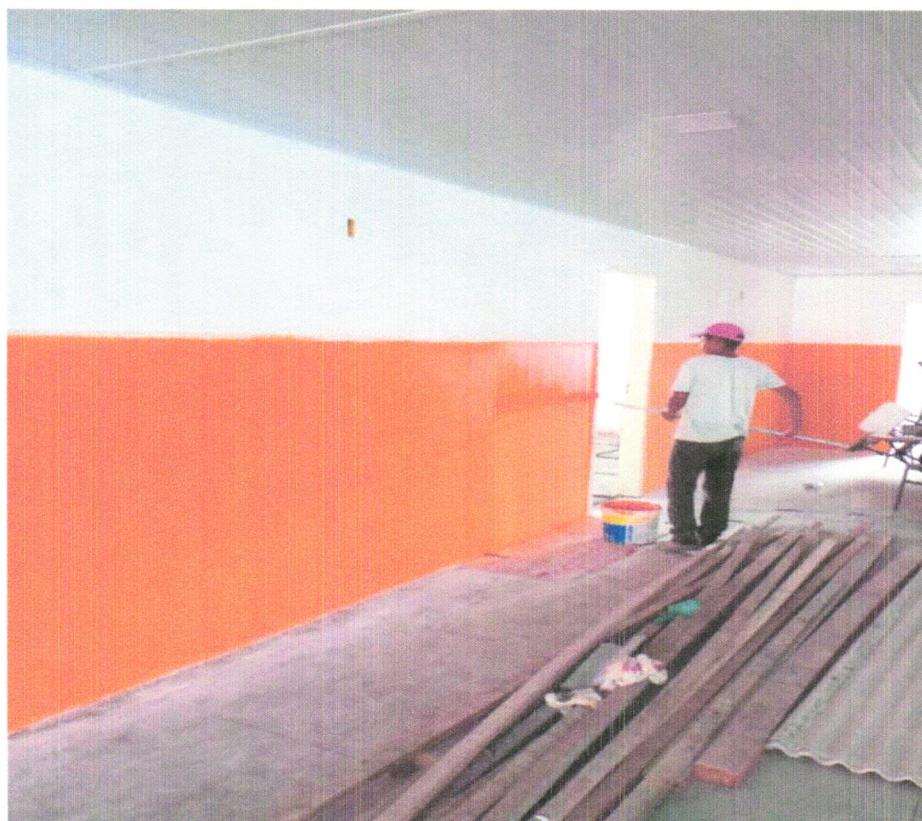
FOTO 18 – EXECUÇÃO DE PINTURA INTERNA
