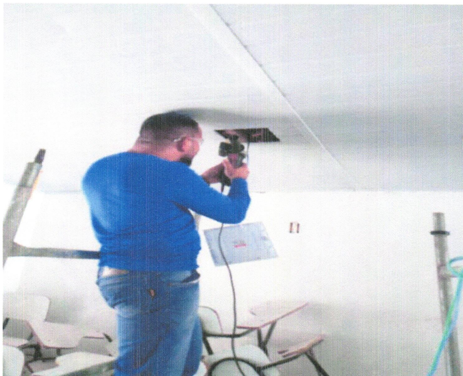
FOTO 12 – INSTALAÇÃO DE LUMINÁRIAS LED
