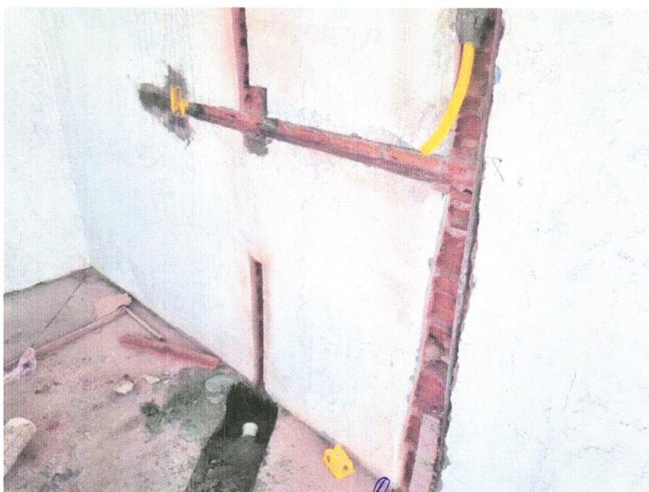
FOTO 10 – INSTALAÇÃO ELÉTRICA E HIDRÁULICA PARA LAVANDERIA
