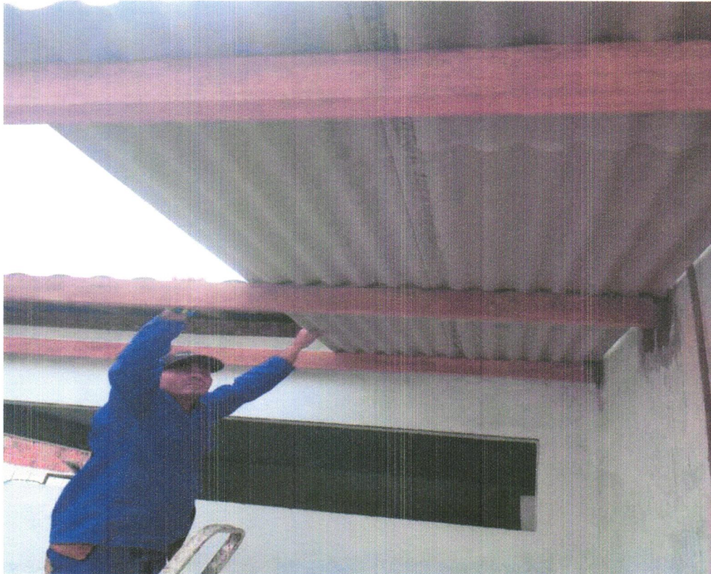
FOTO 08 - EXECUÇÃO DE COBERTURA DE FIBROCIMENTO
