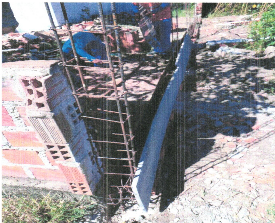
FOTO 16 – EXECUÇÃO DE ALVENARIA DO MURO
