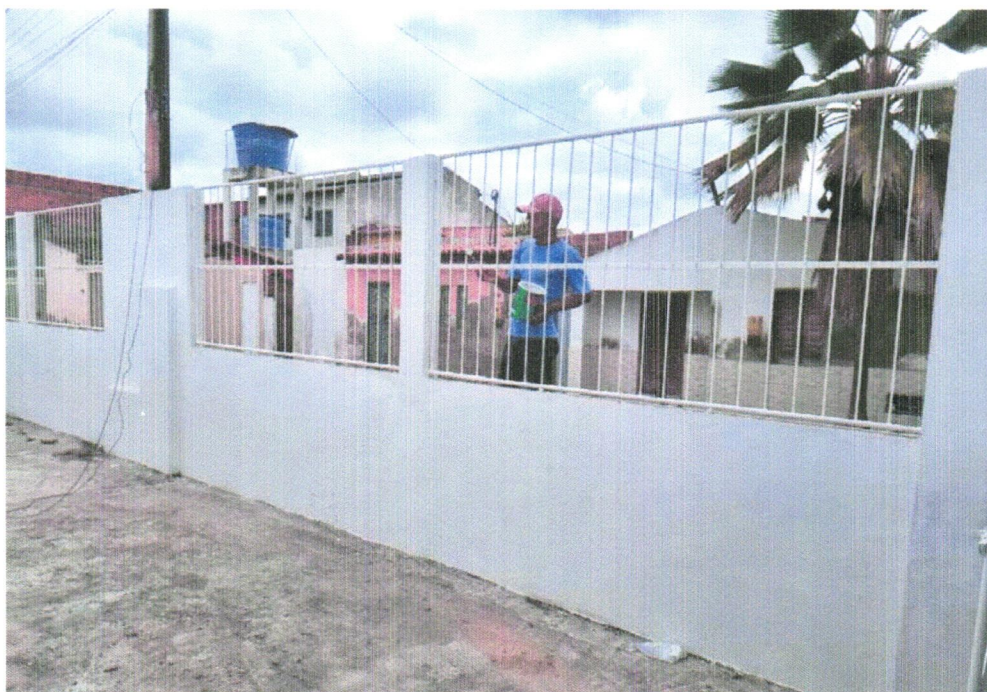
FOTO 20 – EXECUÇÃO DE PINTURA EM ESTRUTURA METÁLICA
