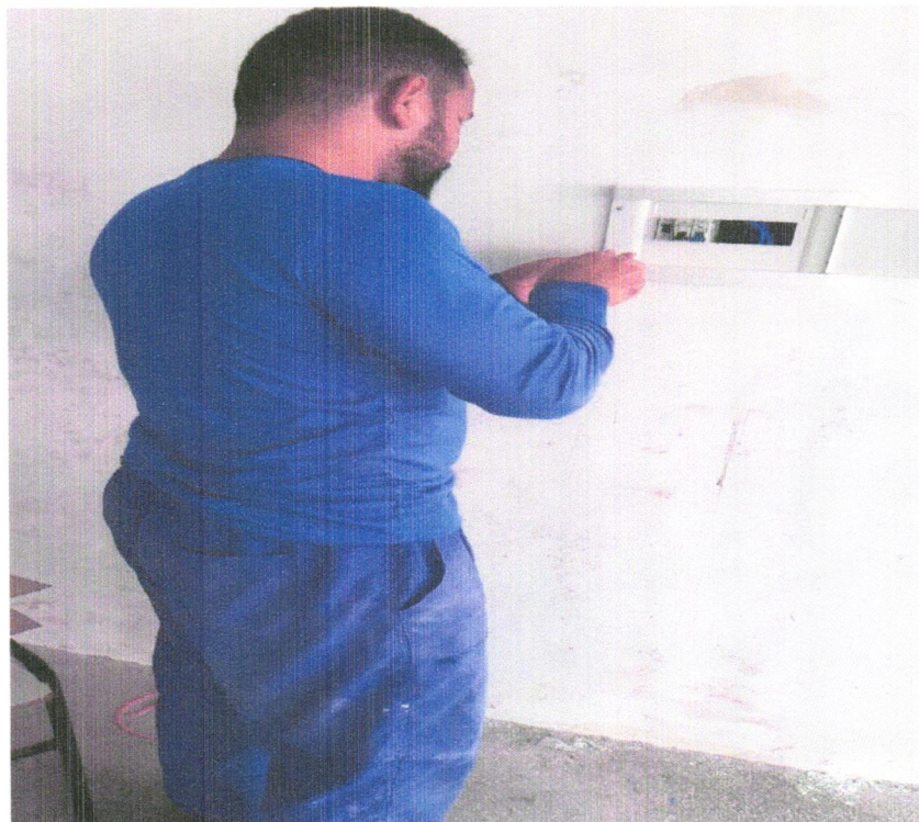
FOTO 06 - INSTALAÇÃO DO QUADRO DE DISTRIBUIÇÃO
