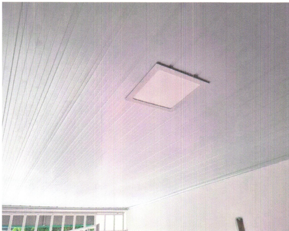
FOTO 13 – INSTALAÇÃO DE LUMINÁRIAS LED
